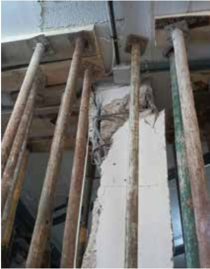
Figura 8.29 Apeos de Urgencia: Daños en cabeza pilar y refuerzo en pilar inferior.
