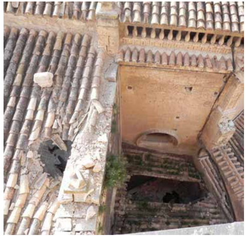
Figuras 4.103 y 4.104 48 : Esquema e imagen derrumbe parcial de cubierta de la Colegiata por impacto en Lorca.
