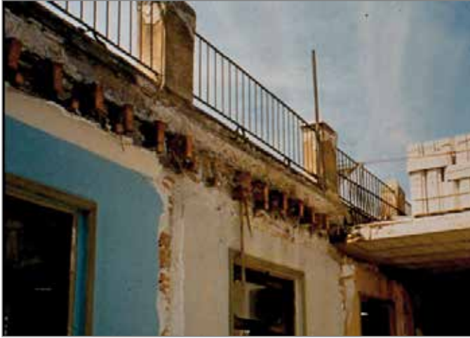
Figura 10.13. Rehabilitación de edificio en Murcia, con viguería de madera.
