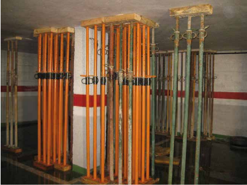
Figura 8.18. Apeo supletorio: Tornapuntas metálicos verticales con durmientes y sopandas de madera
