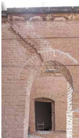
Figura 9.49. Estado previo y final de algunos de los contrafuertes en la Iglesia de Santiago.
