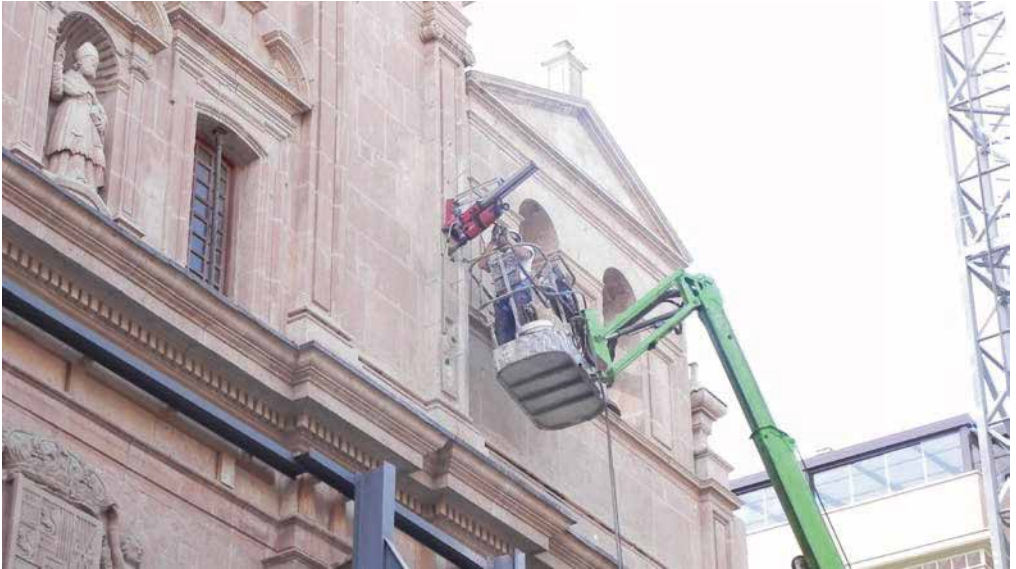
Figura 9.46. Cosido dinámico de la Fachada principal de la Iglesia de Nuestra Señora del Carmen.
