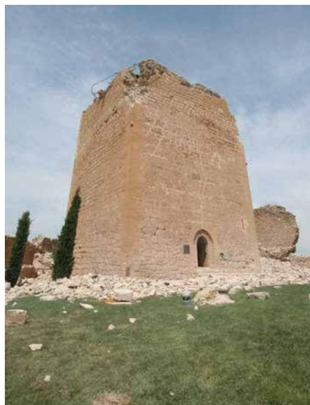
Figura 4.105: Torre del Espolón.
