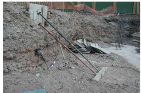
Figura 8.27 Detalle apeo cimentación. Broto, Apeo cimentación.
