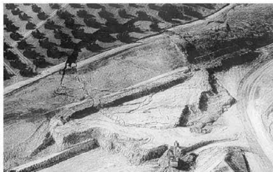
Figura 1.16. Deslizamiento de ladera.
