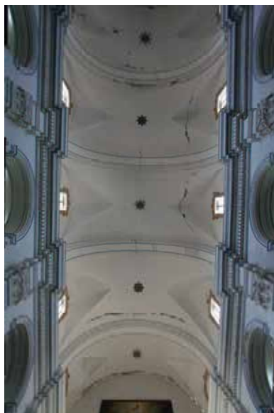
Figura 4.162. Iglesia de San Mateo. Bóveda nave.
