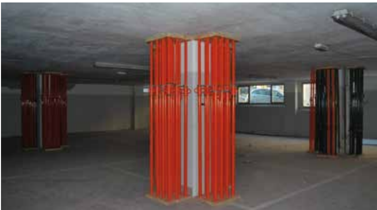
Figura 8.68. Ejemplo con puntales reales colocados en forjado reticular en una planta sótano.
