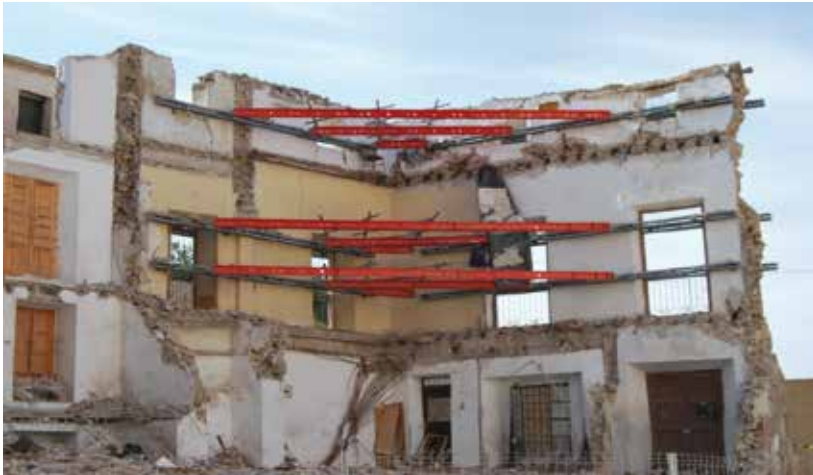
Figura 8.47 Arriostramiento de muros con sistemas industrializados
