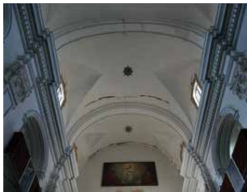
Figuras 4.66 y 4.67: Esquema de deformación e imagen de bóveda fracturada en encuentro con arcos fajones. Lorca.
