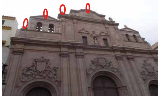
Figura 9.3. Intervenciones de emergencia para retirar las imágenes, pináculos u otros elementos inestables o peligrosos, tras los terremotos de mayo de 2011. Arriba, Nuestra Señora del Carmen; Centro: Ex Colegiata de San Patricio; Debajo: Iglesia de Santiago.
