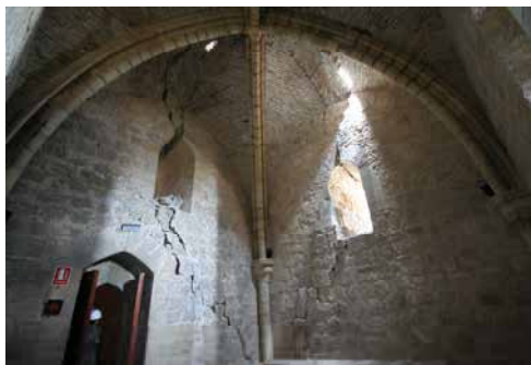
Figura 4.123: Interior primer cuerpo. Torre del Espolón.
