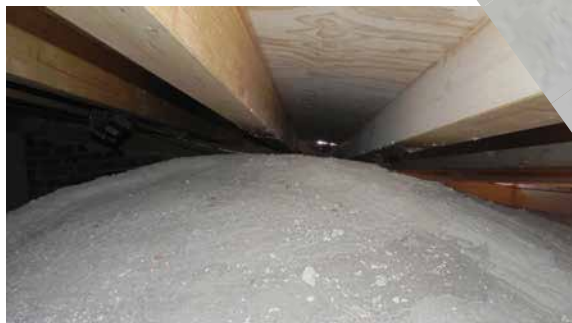
Figura 9.42. La cúpula de la Capilla del Sacramento en la Iglesia de Santiago, durante los trabajos de su reconstrucción, a base de roscas tabicadas, así como la nueva estructura de madera de la cubierta.
