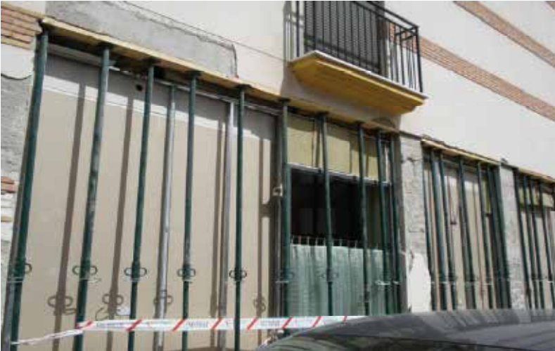
Figura 8.7. Diseño de apeo de pilar.
