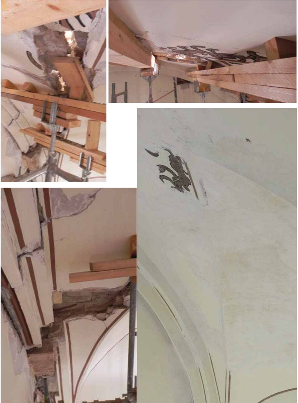
Figura 9.36. Diversas fotografías de la bóveda del crucero del lado del Evangelio de la Iglesia de Nuestra Señora del Carmen en los distintos momentos de su reparación.
