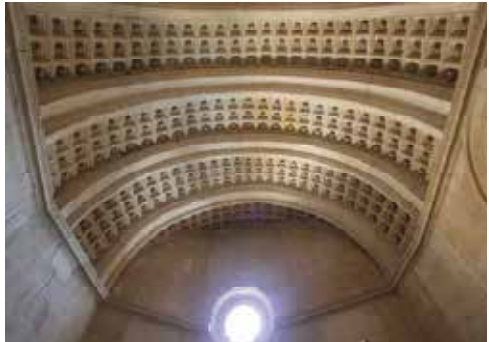
Figura 4.110: Bóveda de la sacristía. Colegiata.
