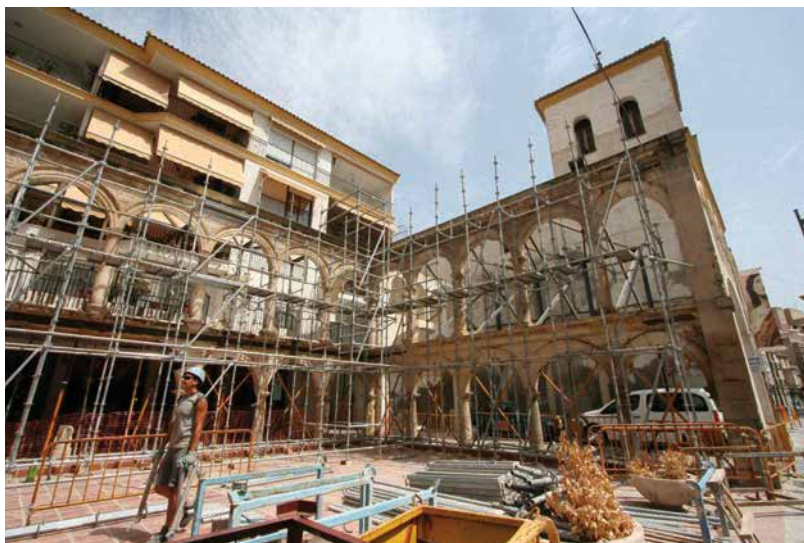
Figura 9.64. Claustro de Santo Domingo. Desmontaje de sillares.
