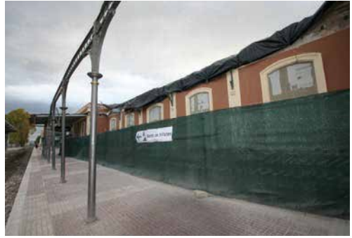
Figura 4.119: Estación de ferrocarril Lorca-Sutullena.
