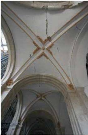
Figuras 4.69 y 4.70: Línea de rotura que recorre espino de bóvedas y arcos en la Iglesia de Santiago y San Diego. Lorca.
