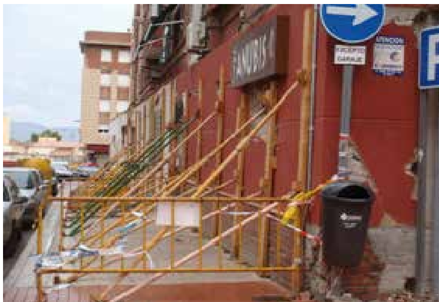
Figura 8.25 Apeos de Emergencia. Lorca. Mayo 2011.
