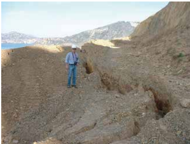
Figura 1.19. Cabecera de una rotura circular incipiente.
