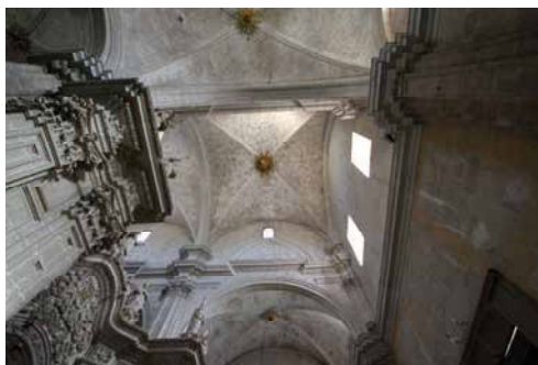
Figura 4.113: Bóvedas arista nave central y laterales.
