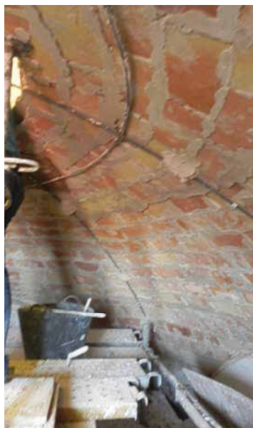
Figura 9.41. La cúpula de la Capilla de la Epístola en la Iglesia de Santiago, durante los trabajos de su reconstrucción, a base de roscas tabicadas.
