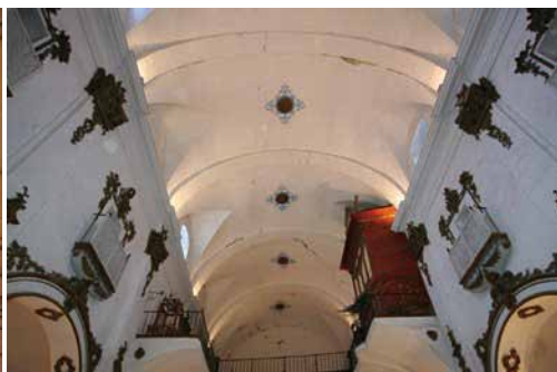
Figura 4.158. Iglesia de San Francisco. Bóveda nave central.
