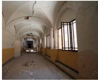
Figura 4.51: Esquema de desplome de fachada con arrastre interior de estructura y bóvedas.
