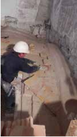
Figuras 4.5 y 4.6: Detalles de la restauración de bóvedas partidas o desplomadas, mediante la ejecución de una o dos roscas de ladrillos, tomados con cal y yeso.
