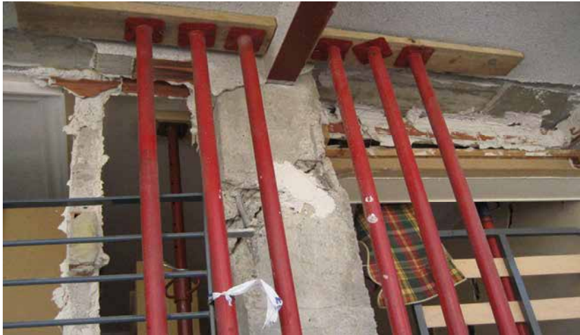
Figura 8.37. Apeo de urgencia pero con carácter supletorio, realizado con puntales telescópicos metálicos para transmisión de carga vertical al suelo o planta inferior.
