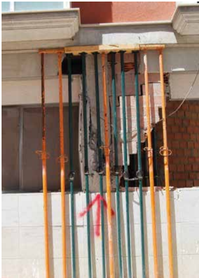
Apuntalamiento de urgencia. Lorca Mayo 2011
