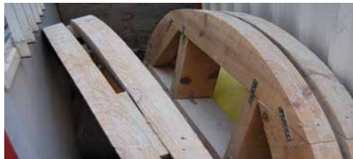
Figura 8.43. Cimbra de madera para el Antiguo Claustro de Santo Domingo.
