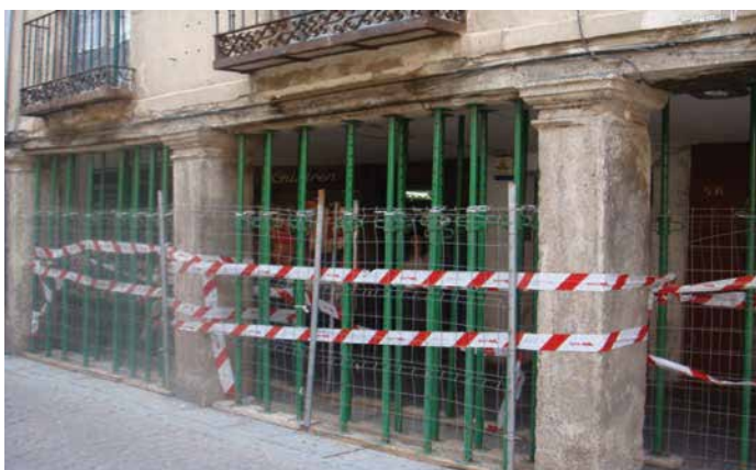
Figura 8.22. Apeo de una edificación en el centro de Guadalajara.
