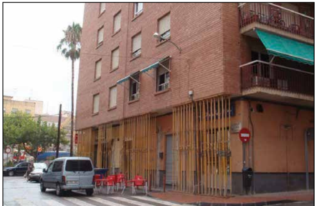
Figura 8.1. Apeo provisional en voladizo de fachada
