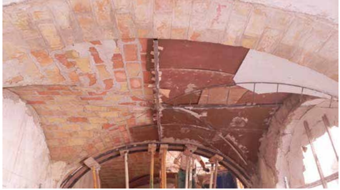
Figuras 4.5 y 4.6: Detalles de la restauración de bóvedas partidas o desplomadas, mediante la ejecución de una o dos roscas de ladrillos, tomados con cal y yeso.
