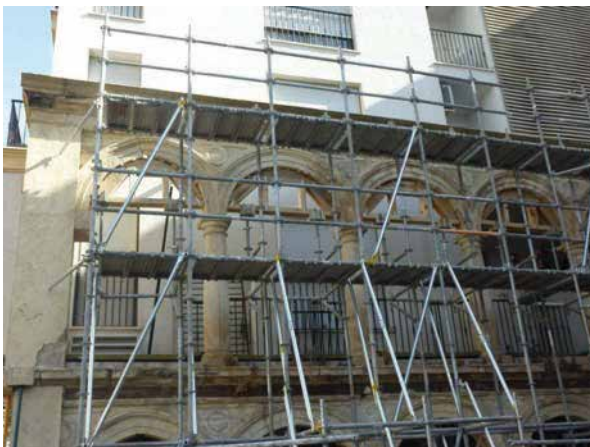
Figura 8.54. Sistema de andamio estructural, realizado a base de tubos de acero con rosetas soldadas al mismo cada 50 cm. para facilitar el anclaje de piezas transversales o inclinadas. En este caso usado como sistema de apeo, con montaje rápido que garantiza el arriostramiento eficaz.
