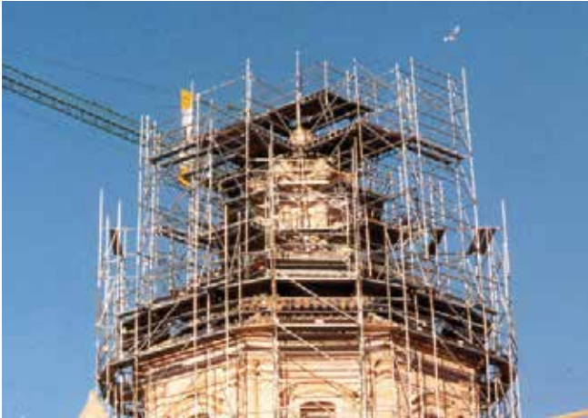
Figura 10.40. Andamio modular. Basílica Los Jeronimos. Murcia.
