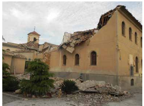
Figuras 4.15, 4.16 y 4.17: Hipótesis de colapso de la estructura de cerchas de cubierta de la Iglesia del Convento de las RRMM Clarisas, partiendo el muro de apoyo de estas en el lado más débil y donde no tiene impedidos los grados de libertad de movimiento. A la derecha, fotografías de dicho colapso.
