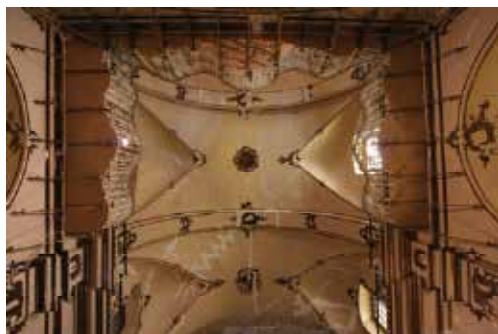
Figura 4.157. Capilla del Rosario. Bóveda nave central.
