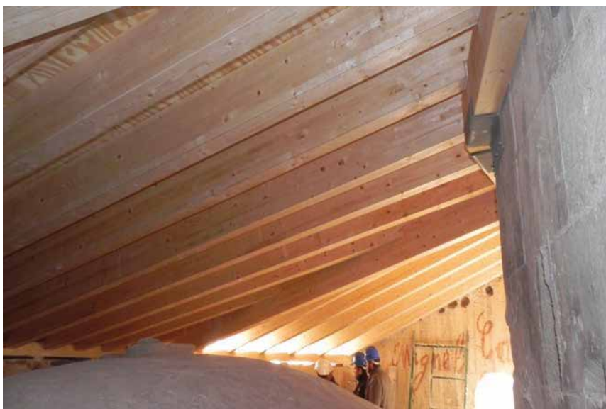
Figura 9.54. Diversas fotografías del desmontaje de cubiertas de hormigón o metálicas y ejecución de nuevas estructuras de madera en la Ex Colegiata de San Patricio.
