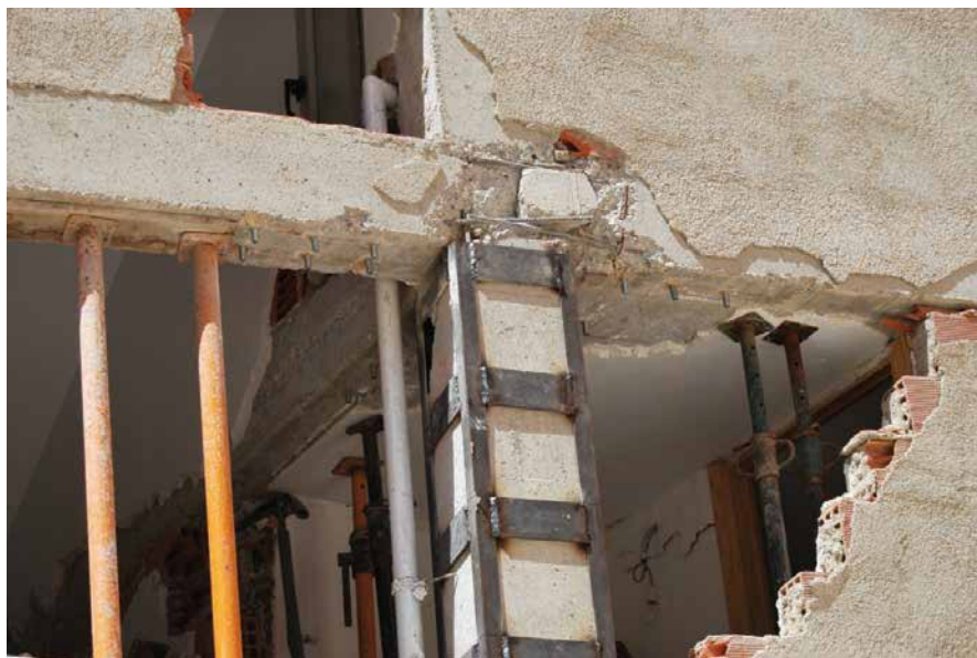
Figura 8.20. Apeo supletorio: Apeo de forjado y refuerzo definitivo del pilar.
