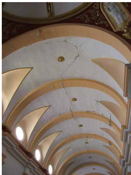
Figura 4.161. Iglesia San Cristóbal. Bóveda nave.
