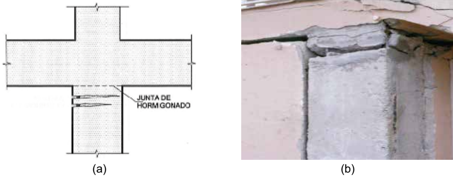
Figura 3.20. (a) Fisura horizontal en cabeza de pilar (Fuente: Calavera, 2005). (b) Pilar agotado por agrietamiento horizontal (Fuente: Muñoz, 2009)
