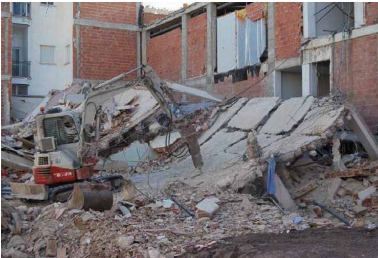
Figura 10.11 Demolición de un forjado reticular. Lorca Mayo 2011.
