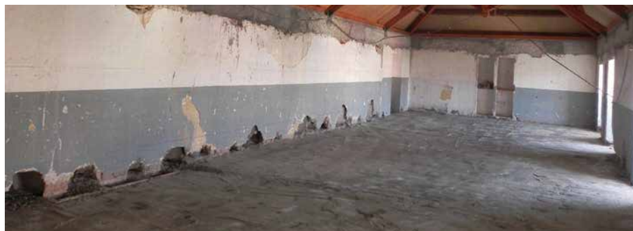
Figura 9.52. Diversos momentos de los trabajos de recuperación de la capacidad portante de los forjados del Monasterio de San Francisco, mediante tornillos berraqueros y capa de compresión con arlita.
