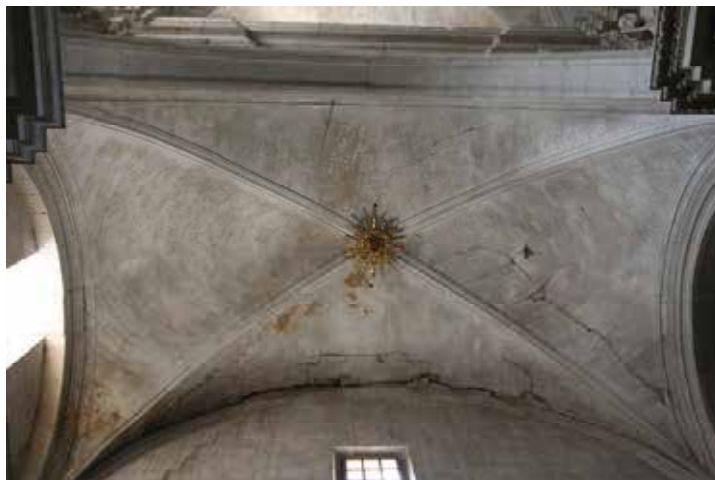
Figura 4.163. Colegiata de San Patricio. Bóveda nave lateral.
