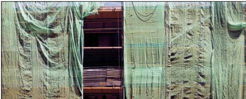
Figura.10.38. Marquesinas y Redes de protección en demolición.
