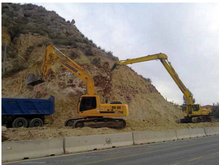
Figura 1.35. Uso de equipos de largo alcance para excavación y saneo.
