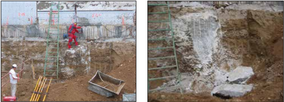
Figura 10.29. Rotura de Zapata hormigón con Morteros expansivos.
