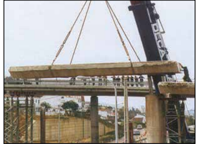
Figura 10.30. Corte de puente con sierra adiamantada.
