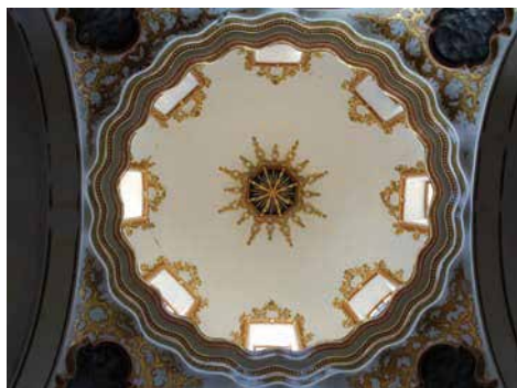
Figura 4.117: Cúpula de la Iglesia del Carmen.
