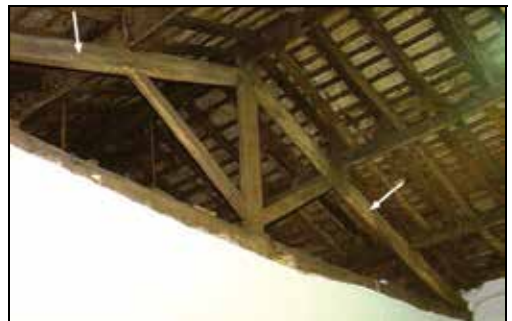
Figura 10.12. Viguetas apoyadas en jácena y soportes en madera y Cerchas de madera.
