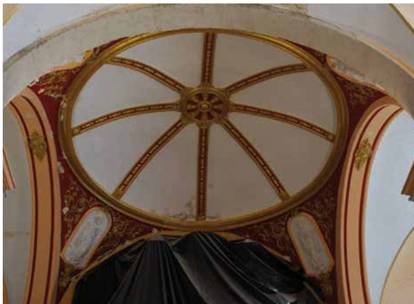
Figura 4.171. Iglesia de San Cristóbal. Cúpula.
