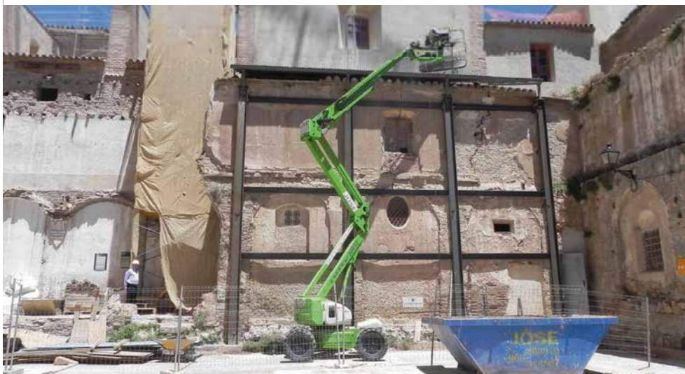
Figura 9.45. Distintas fases de la colocación de los apeos en los muros del claustro de la Iglesia de Nuestra Señora del Carmen.
