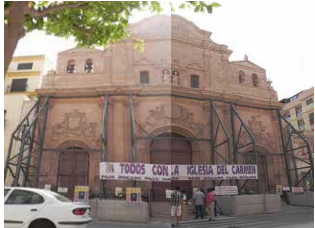
Figura 9.5. Apeo de emergencia colocado en la fachada principal de la Iglesia de Nuestra Señora del Carmen, una vez que se comprobó el movimiento de desplome de la misma hacia la calle.
