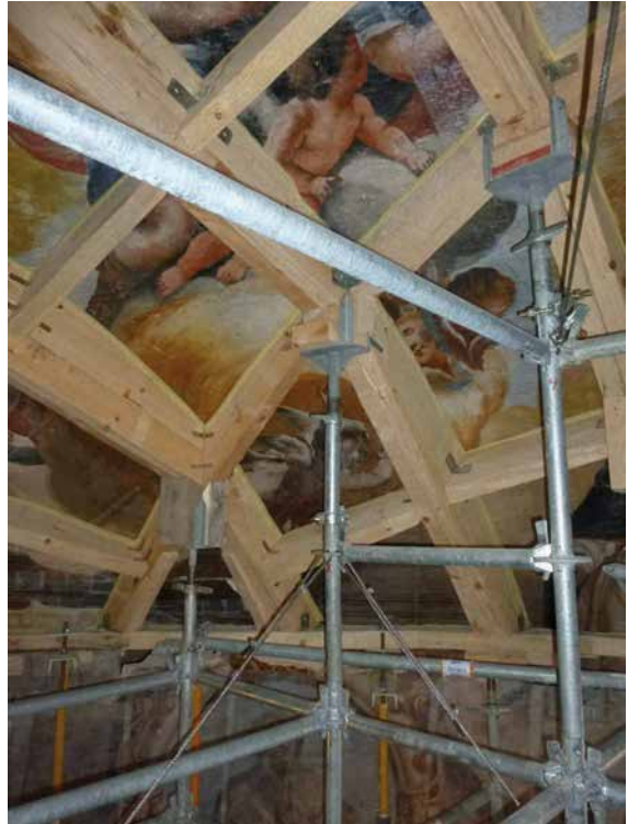
Figura 8.56. Apeo supletorio de bóveda formado con un andamio estructural tipo Sistema Peri Up Rosett, mediante puntales telescopios o tubos de acero a los que se sueldan cada 50 cm. rosetas del tipo Peri Up Rosett.
