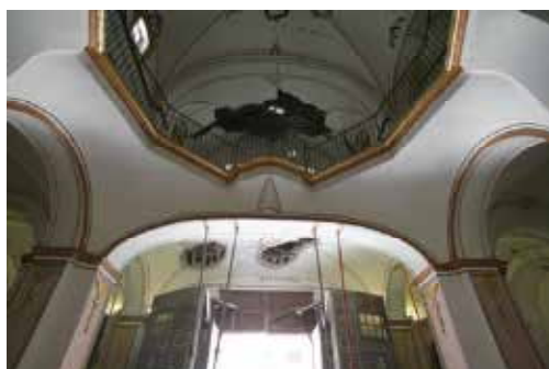
Figura 4.160. Iglesia del Carmen. Bóveda nave central y coro.
