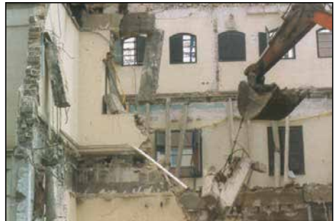
Figura 10.26. Demolición por tracción.
