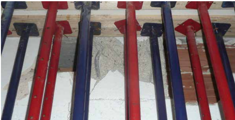
Figura 8.4 Edificio ubicado en la Calle Auroros de Lorca.
