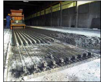
Figura 10.17. Fabricación de hormigón pretensado.
