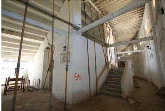
Figura 4.149. Plaza de toros. Muros radiales de ladrillo.
