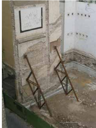
Figura 8.31. Apeos de muro.
