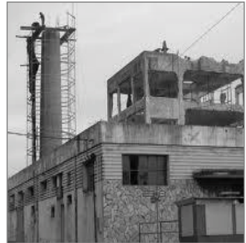
Figura 10.15. Demolición de chimenea.
