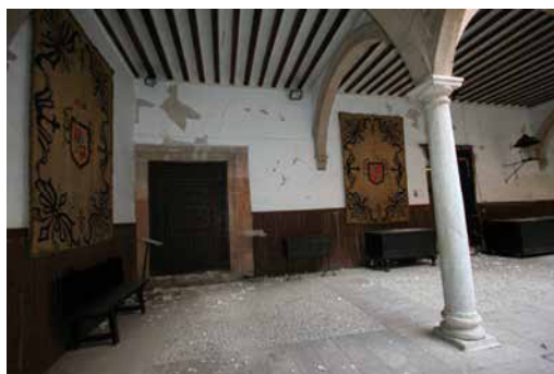
Figura 4.136. Palacio Guevara. Patio.
