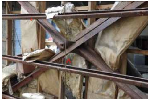
Figura 2.14. Pandeo lateral de las diagonales (Fuente: Ávila, 2011)
