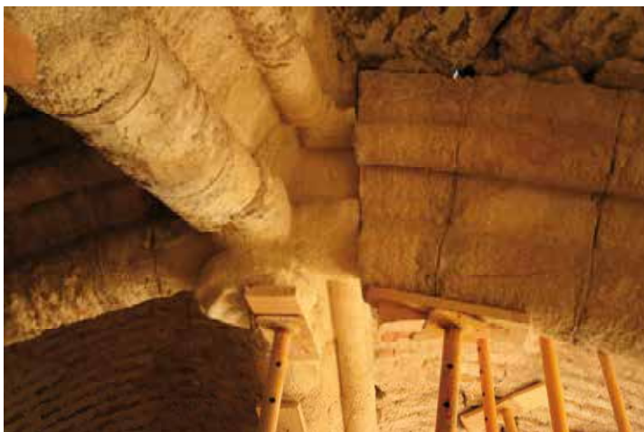
Figura 4.152. Torre del Espolón. Descenso del nervio en bóveda de crucería.
