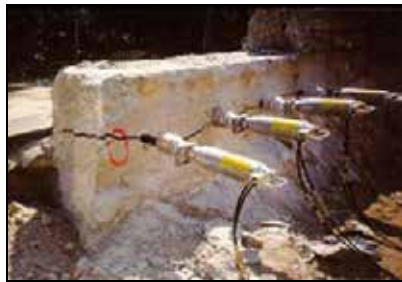
Figura 10.28. Rotura con gatos hidráulicos.
