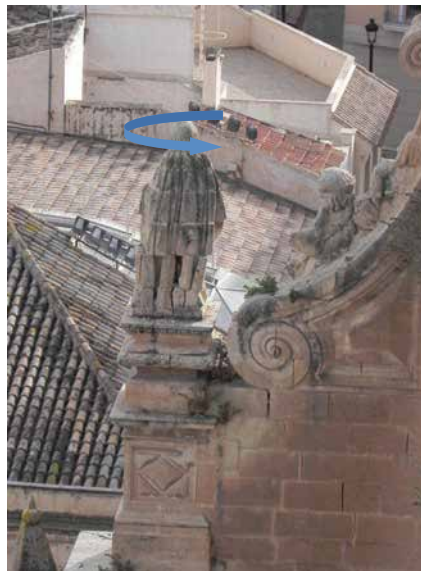
Figura 4.105 49 : Imagen giro respecto a eje vertical de escultura en la fachada principal de la Colegiata de Lorca.
