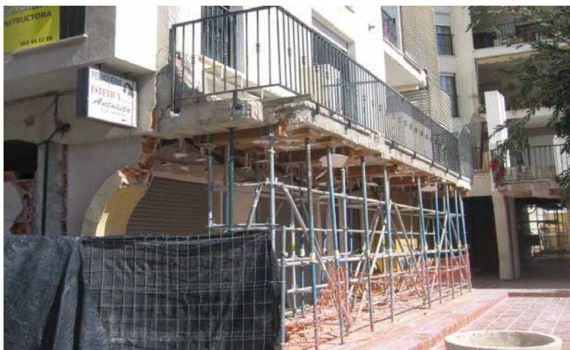
Figura 8.48 Apeo suplementario de un forjado en voladizo o balcón, en Lorca.
