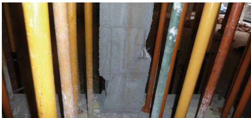
Figura 8.5. Edificio situado en calle Castilla, de Lorca.
