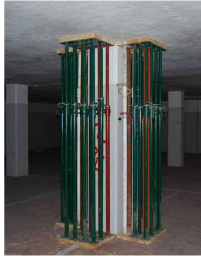
Figura 8.29 Apeos de Urgencia: Daños en cabeza pilar y refuerzo en pilar inferior.
