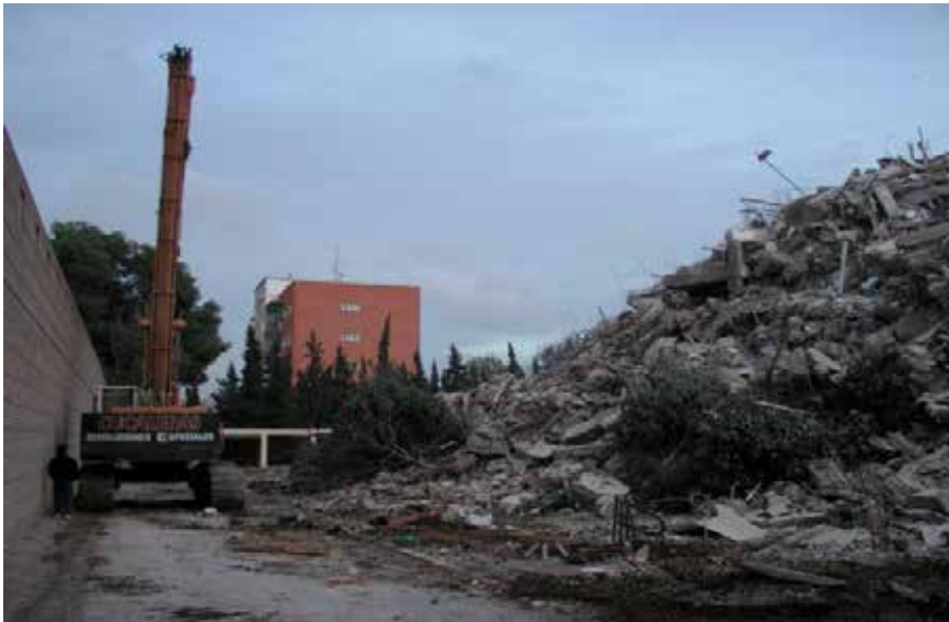
Figura 10.6 Eliminación de escombros.
