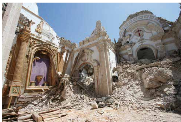
Figura 9.59. Iglesia de Santiago. Retirada de material desplomado.
