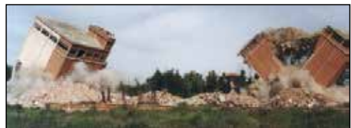
Figura 10.16. Demolición de Silos en Albacete.
