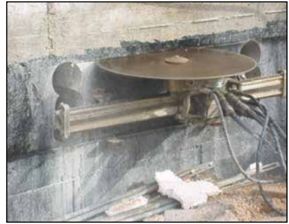
Figura 10.32. Disco de corte en muro de hormigón armado.
