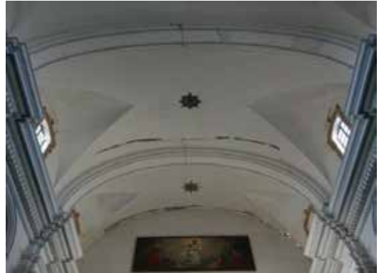
Figuras 4.57 y 4.58: Esquema de mecanismo de daño por deformación simétrica. Deformación con descenso de flecha, grieta en la clave, o cercana a ella. También se observan grietas de separación con la bóveda, Iglesia de San Mateo. Lorca.
