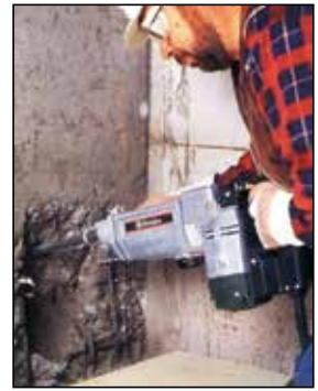
Figura 10.24. Demolición manual en propio centro de trabajo y Martillo neumático manual.
