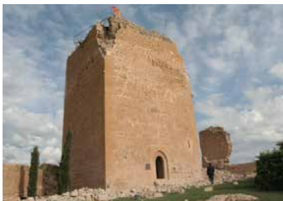
Figuras 4.86 y 4.87 44 : Esquema de expulsión de esquina e imagen de la torre del Espolón. Lorca.
