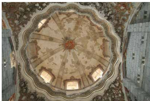
Figura 4.116: Cúpula de la Iglesia de San Juan.
