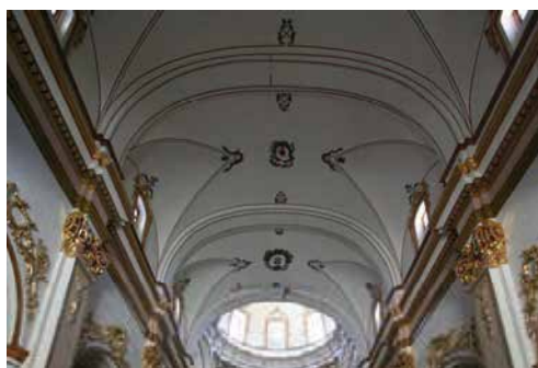
Figura 4.159. Iglesia del Carmen. Bóveda nave central.
