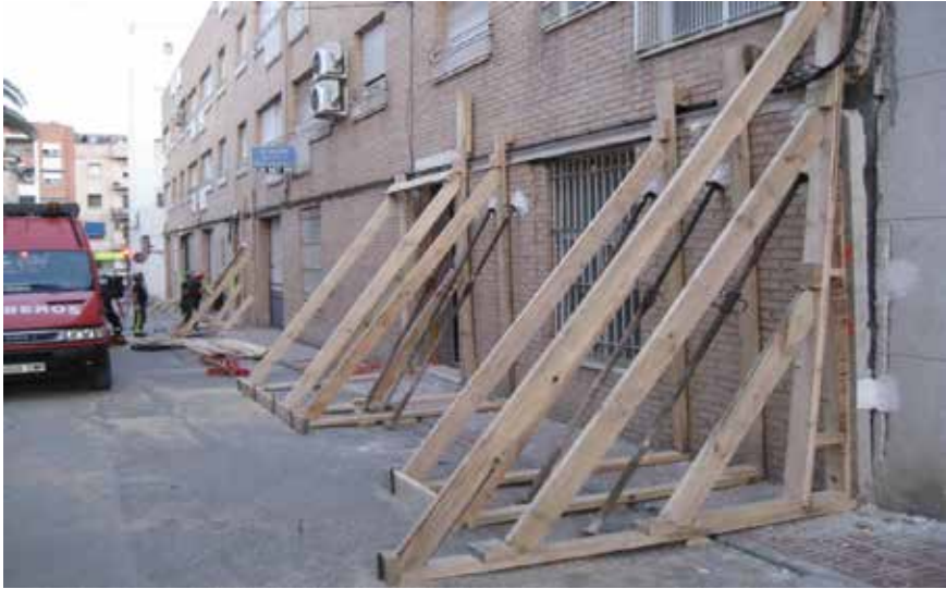
Figura 8.26 Apeo provisional, cerramiento planta baja. Lorca. Mayo 2011.
