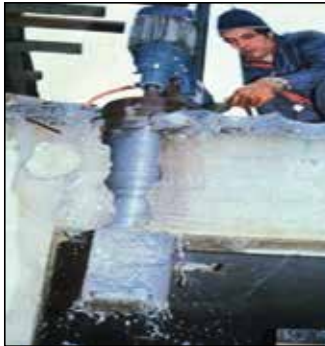
Figura 10.34. Perforación y corte de una jácena de H.A.
