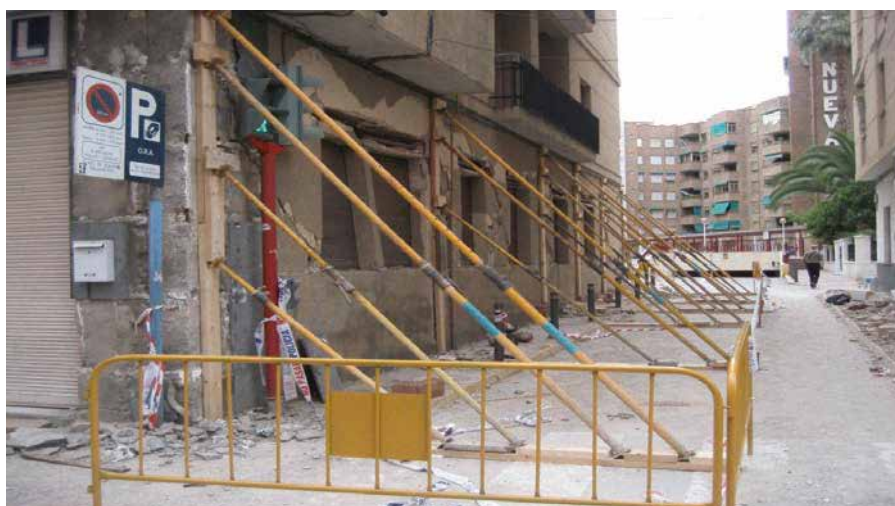
Figura 8.17. Apeo de urgencia o complementario: Tornapuntas metálicos con durmientes y sopandas de madera.
