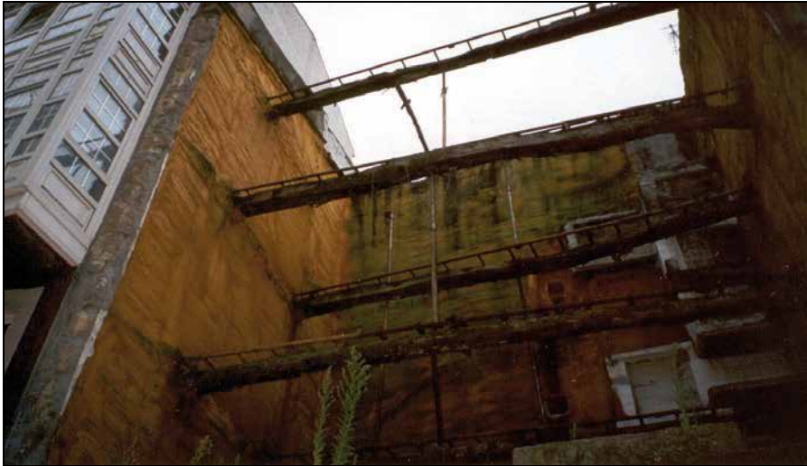
Figura 8.21. Arriostramiento entre dos edificios.
