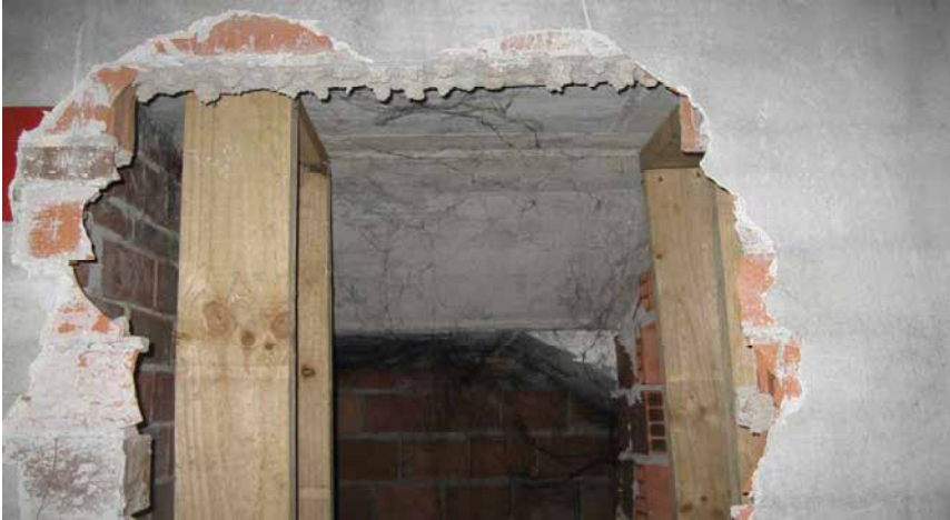
Figura 8.36 Apeo de urgencia sencillo.
