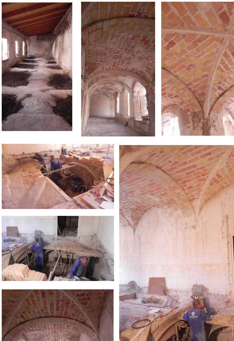
Figura 9.38. Diversas fotografías de la reparación de las bóvedas del claustro de San Francisco (por el trasdós e intradós)
