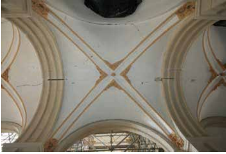
Figura 4.164. Iglesia Santiago. Bóveda nave lateral.
