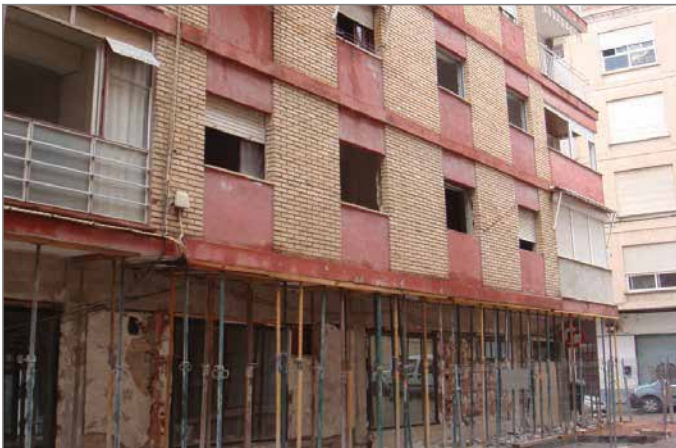
Figura 8.2 Apeos y Refuerzo. Terremoto de Lorca, 2011
