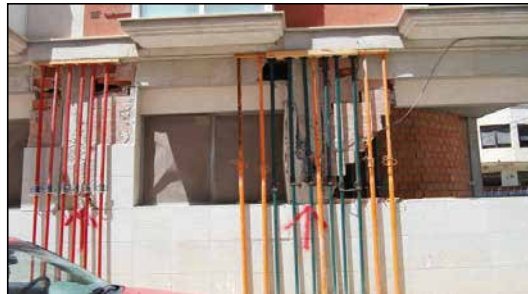
Figura 10.39. Apuntalamiento de emergencia.
