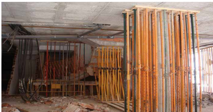
Figura 8.35. Apeo de urgencia de una forjado reticular de HA. Lorca 2011.
