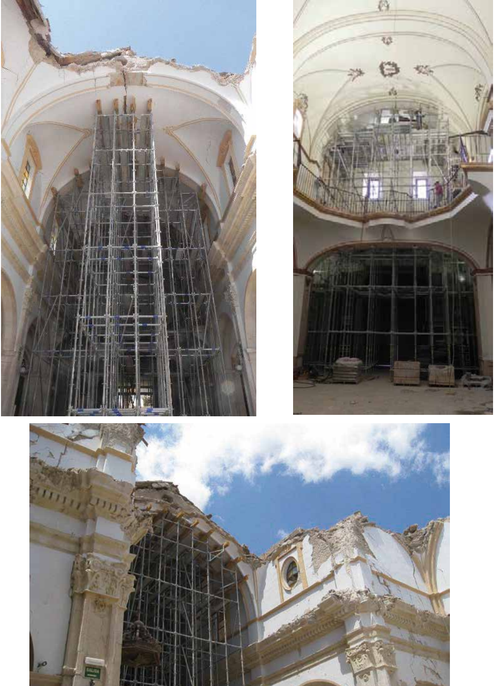
Figura 9.29. Tres imágenes de la instalación de apeos para los arcos y bóvedas de la Iglesia de Santiago Apóstol.
