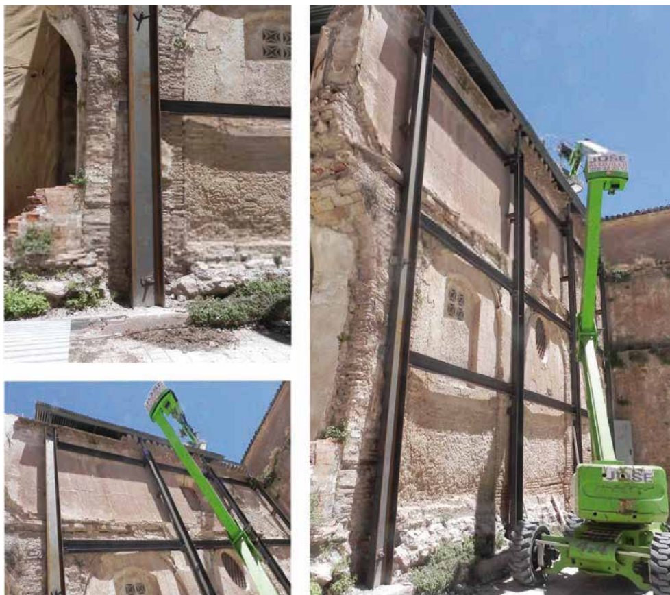
Figura 9.45. Distintas fases de la colocación de los apeos en los muros del claustro de la Iglesia de Nuestra Señora del Carmen.
