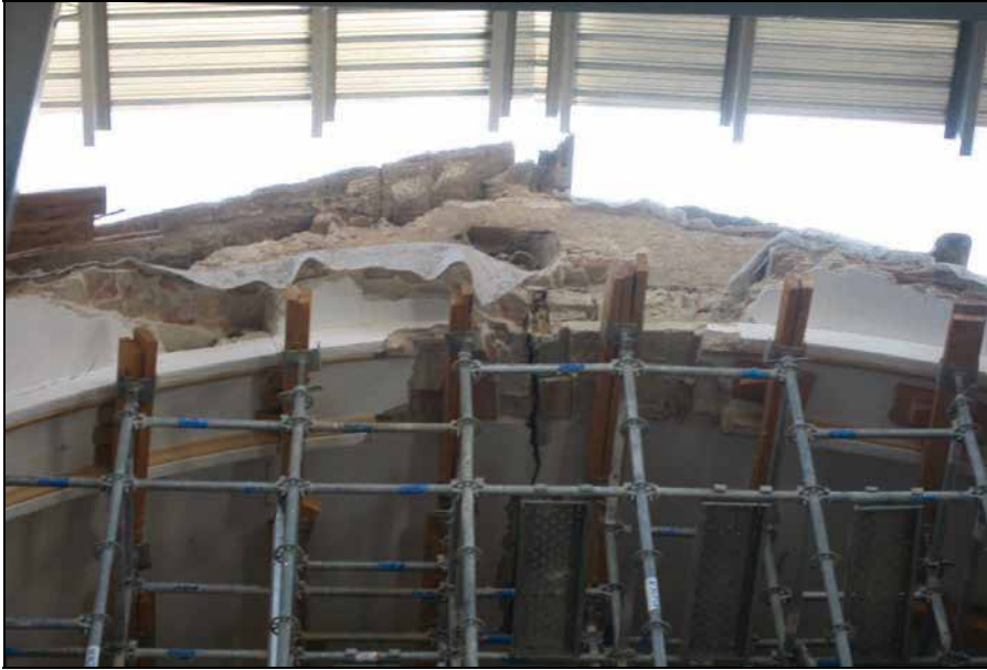
Figura 8.45. Cimbra soportando el Colapso del crucero de la iglesia de Santiago de Lorca.
