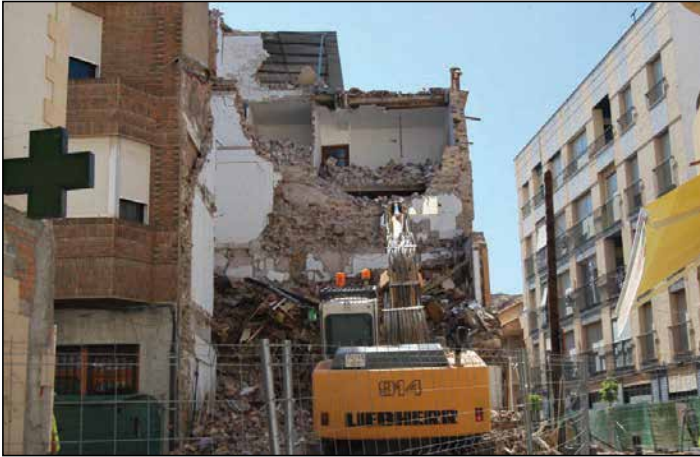
Figura 10.42. Demolicion de edificación mecanicamente. Cerramiento perimetral.
