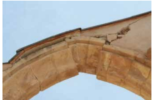
Figura 4.65: Imagen del arco poco cargado de la iglesia de Santa María.
