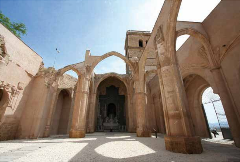
Figura 4.130. Iglesia de Santa María. Planta salón característica del siglo XV con bóvedas de crucería.
