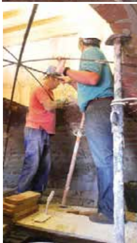
Figura 9.41. La cúpula de la Capilla de la Epístola en la Iglesia de Santiago, durante los trabajos de su reconstrucción, a base de roscas tabicadas.
