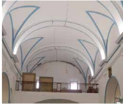
Figuras 4.69 y 4.70: Línea de rotura que recorre espino de bóvedas y arcos en la Iglesia de Santiago y San Diego. Lorca.
