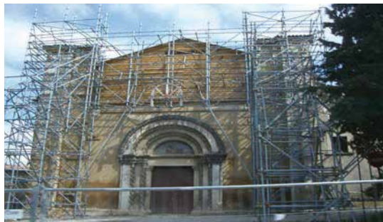
Figura 8.55b. Estabilizador de Fachada. Iglesia Santa María. L'Áquila. Italia.
