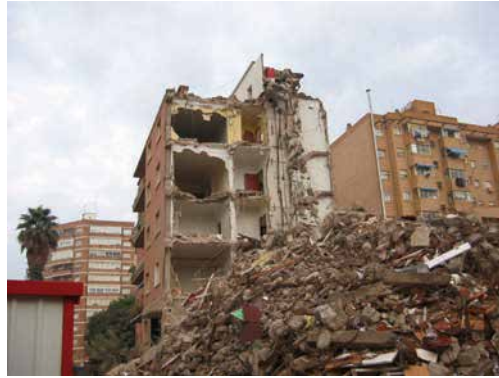
Figura 10.37. Demolición por medios mecánicos. Edificio Trafalgar. Cartagena.
