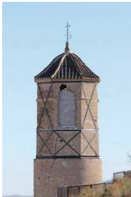
Figura 4.180. Torre de la Iglesia de San Juan.
