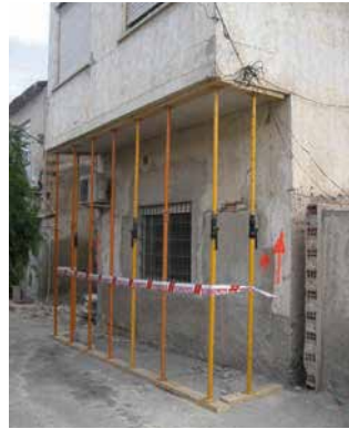
Figura 8.15. Apuntalamiento en voladizo de edificación.
