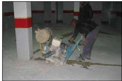
Figura 10.31. Disco de corte en Solera de hormigón.
