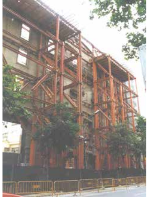
Figura 10.14. Estabilizadores de fachada. Madrid.
