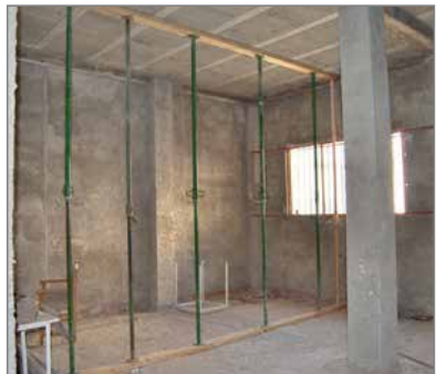
Figura 8.67. Forjado Unidireccional. Sopandas y Durmientes.
