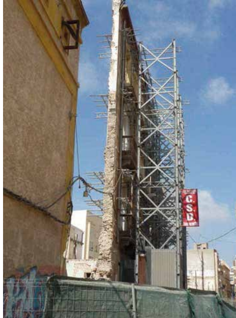
Figura 8.51 a. Fachada en Lorca.
