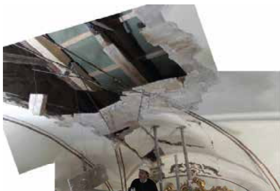
Figura 9.35. Diversas fotografías de la bóveda sobre el coro de la Iglesia de Nuestra Señora del Carmen en los distintos momentos de su reparación.
